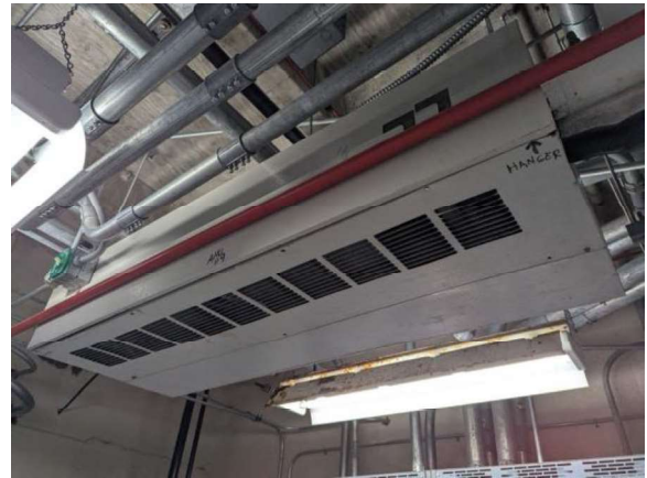
LKMC073e 1/27/2026 Overhead fan coil unit Switchgear room
